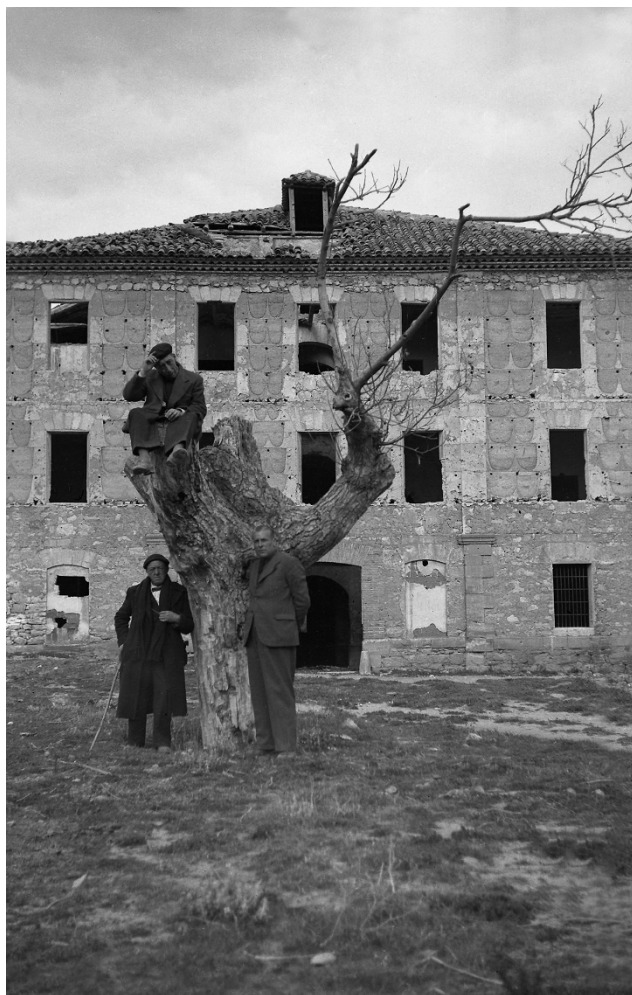
Figura 2 – Fachada principal del edificio de los Baños de Teruel (*)
