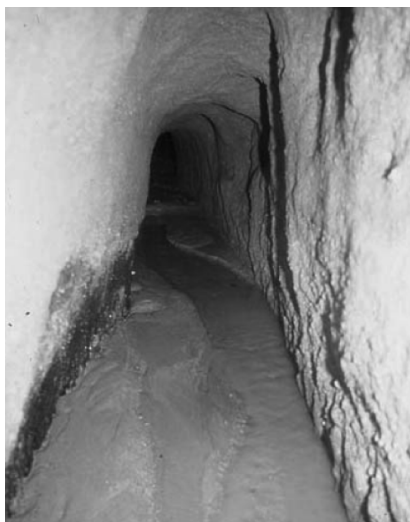
Figura 1 – Galería de viaje de agua
