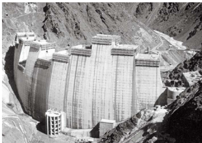
Figura 4 – Presa de El Atazar en construcción
